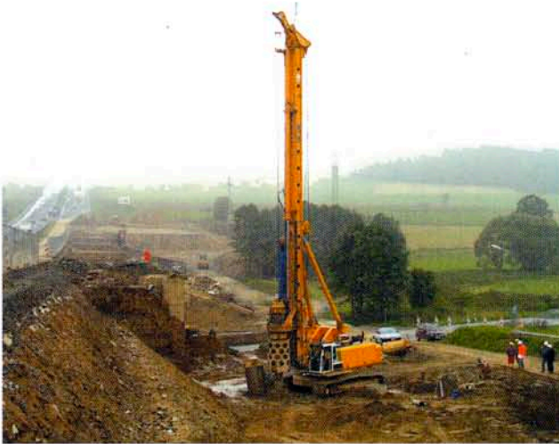
Bohrpfahlarbeiten
