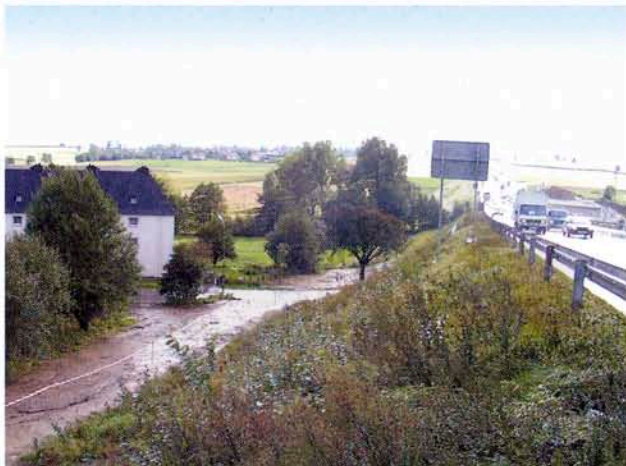
Ansicht Münchberger Senke vor Brückenbau
