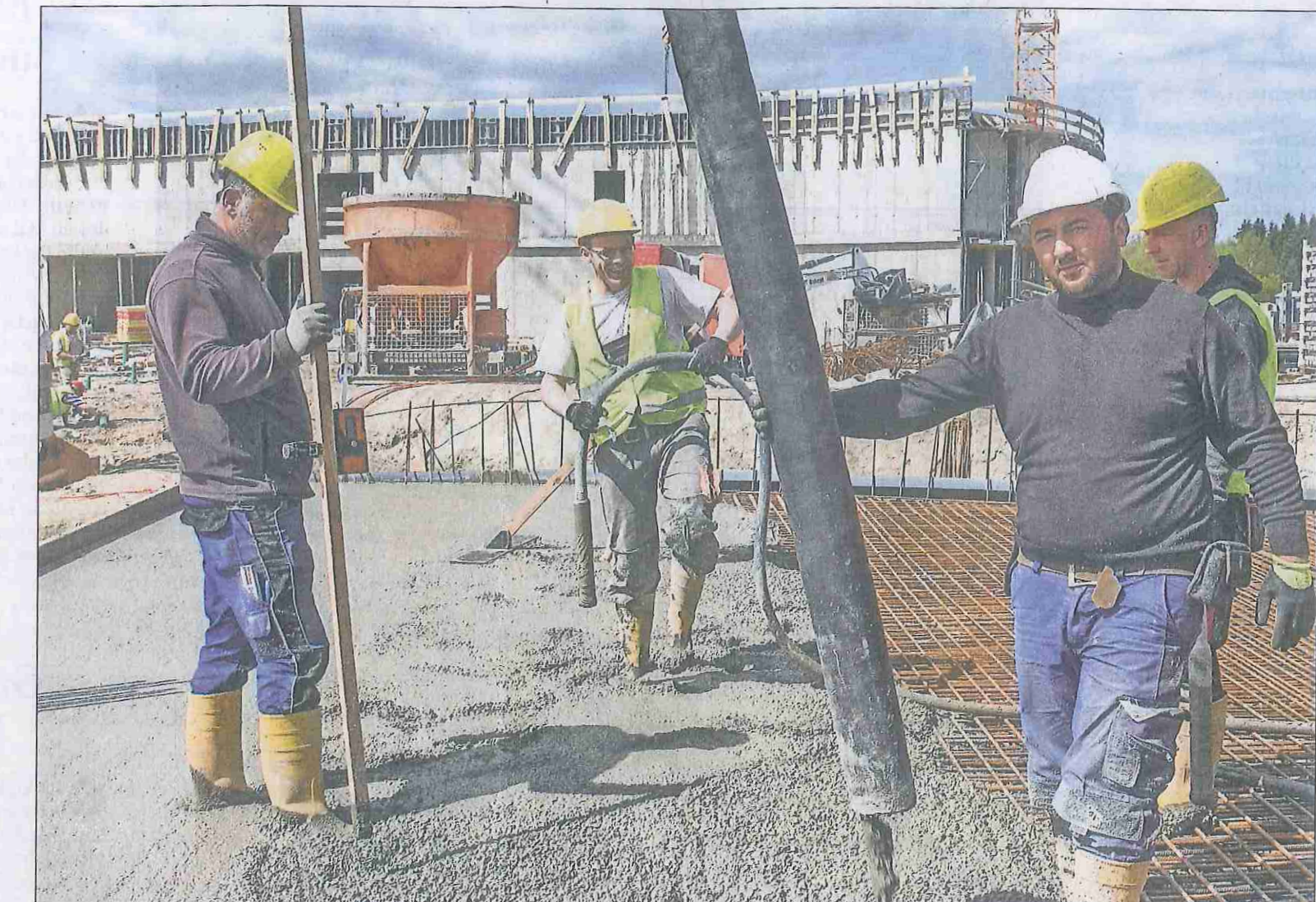
Die Bauarbeiter haben zurzeit alle Hände voll zu tun, die Betonierungsarbeiten am Kurzentrum Siebenstern, das bei der Grundsteinlegung einen neuen Namen erhalten wird, voranzutreiben.
