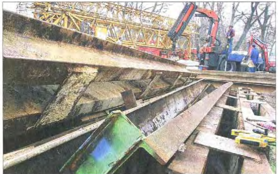
Die Spundwände für den Anbau wurden gestern morgen geliefert.
