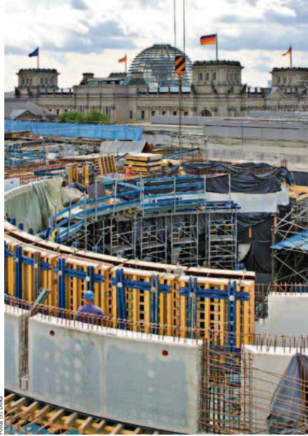
Die Rotunde im Gebäudezentrum wird mit einer Trägerschalung Top 50 geschalt. Zwischengeschaltete Kranzhölzer dienen dazu, den Durchmesser von bis zu 27,50 m exakt abzubilden.
