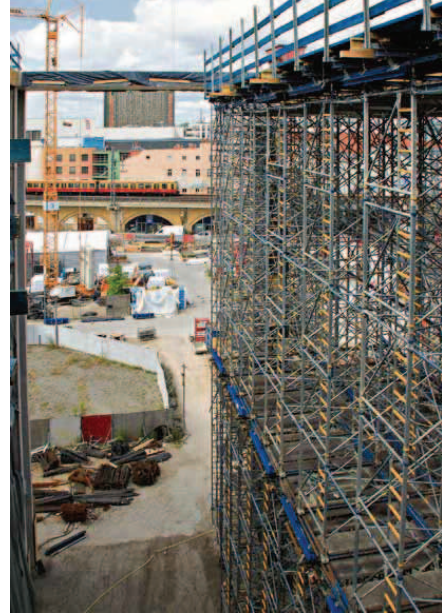
Die 22,00 m hohe Unterstellung aus Staxo 100 kann am Gebäude nicht angehängt werden und ist daher statisch freitragend gerechnet.
