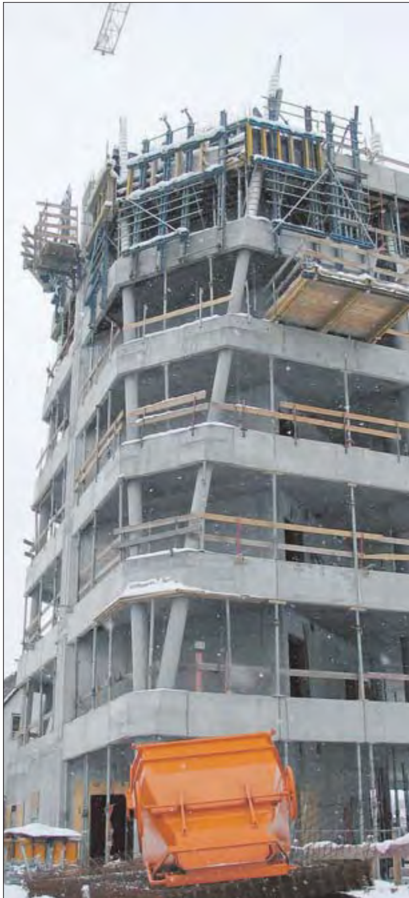
Der halbe Turm steht schon – so sehen sechs Stockwerke von unten aus.
