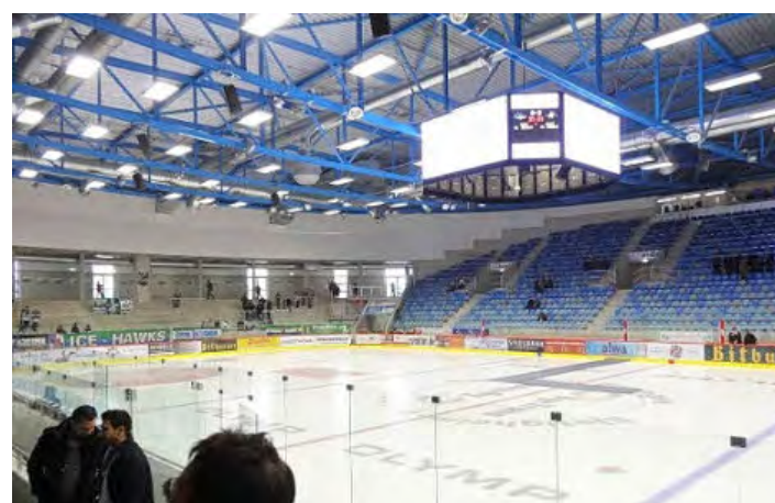
Die Ege Trans-Arena in Bietigheim-Bissingen ist eine der Visitenkarten der Firma Dechant Hoch- und Ingenieurbau-GmbH. Foto: dhib
