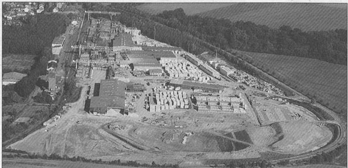
Auslandsauftrag: Ein Großsägerwerk errichtet die Firma Dechant Hoch- und Ingenieurbau zurzeit in Schweden. Hier sind 20 Mitarbeiter aus Weismain in zwei Kolonnen im Einsatz. Foto: red
