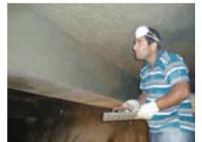
Anarbeiten der Deckschicht des Spitzbetons (verreiben bzw. egalisieren)
