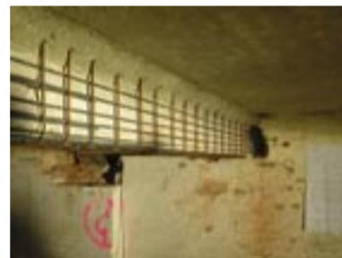
Statisch wirkende Schub- bzw. Schwindbewehrung der Unterzüge
