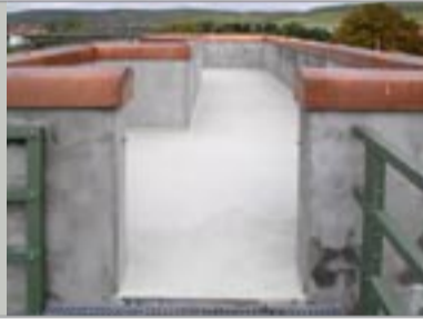
Fertige Sanierung Stahlbetonbrüstung auf Kraftwerkspfeiler
