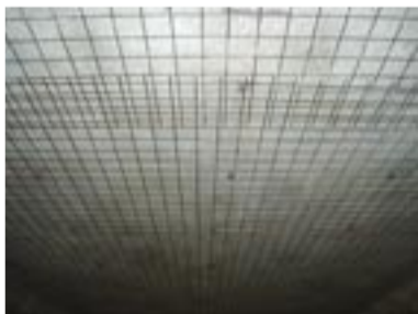
Konstruktiv angebrachte Rissbewehrung an den Deckenuntersichten
