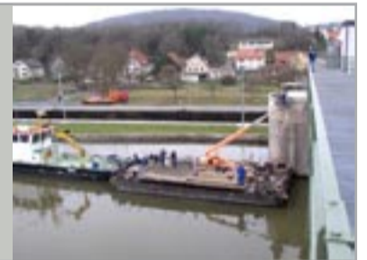
Rückbau Hängegerüst Pfeilerkopfschalung vom Wasser aus
