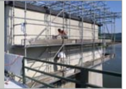
Putzsanierung Wehrantriebshaus mit Hängegerüst
