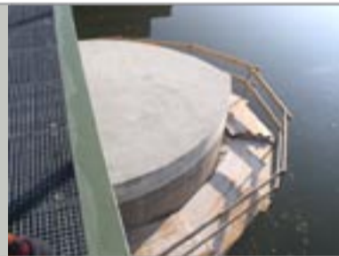
Pfeilerkopfsanierung im Oberwasserbereich
