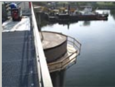
Pfeilerkopfsanierung im Oberwasserbereich
