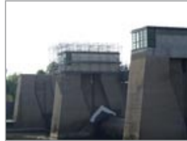
Putzsanierung Wehrantriebshaus mit Hängegerüst 15m über der Wasseroberfläche
