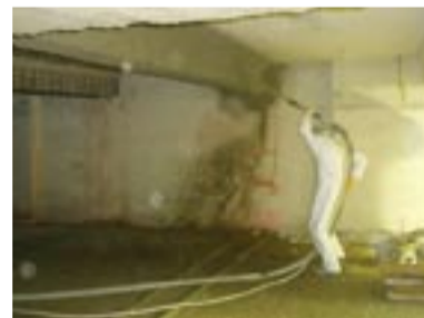
Auftragen der ersten bzw. statisch wirkenden Spitzbetonschicht
