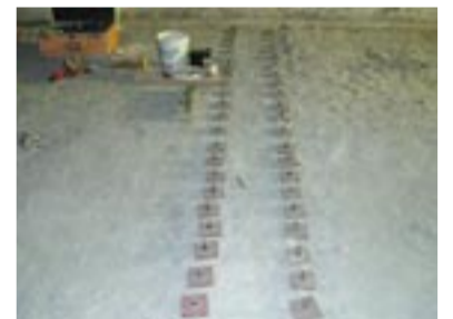
Endverankerung der Schubbügel mittels aufgeschraubten Stahlplatten an der Deckenoberseite
