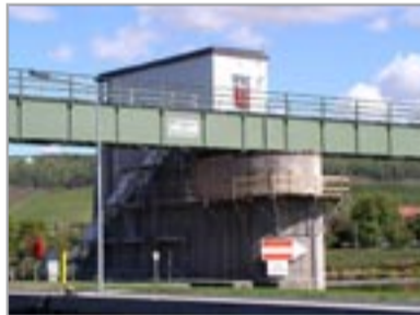
Pfeilerkopfsanierung mit Rissverpressung
