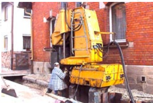
Erschütterungsfreie Preßarbeiten am Kanal Coburg
