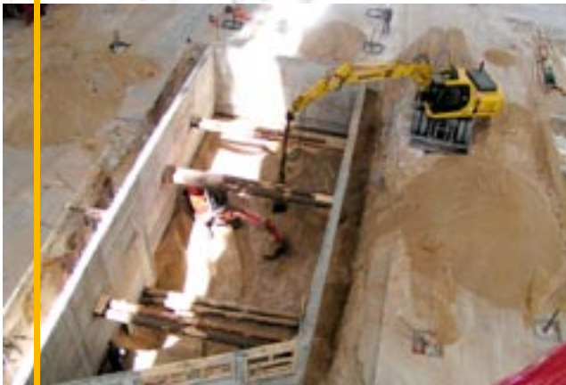
Senkkasten nach Voraushub für Schwallwasserbecken „The Tropical Islands“ bei Berlin, Tiefe rund 4,50 m, Abmessungen ca. 12 x 20 m
