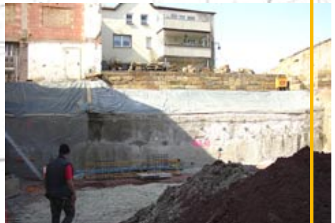
Spritzbetonnagelwand beim ZOH in Bayreuth
