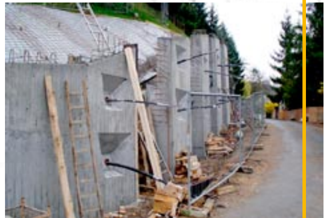
Mit Dauerankern gehaltene Stützwand in Bensheim
