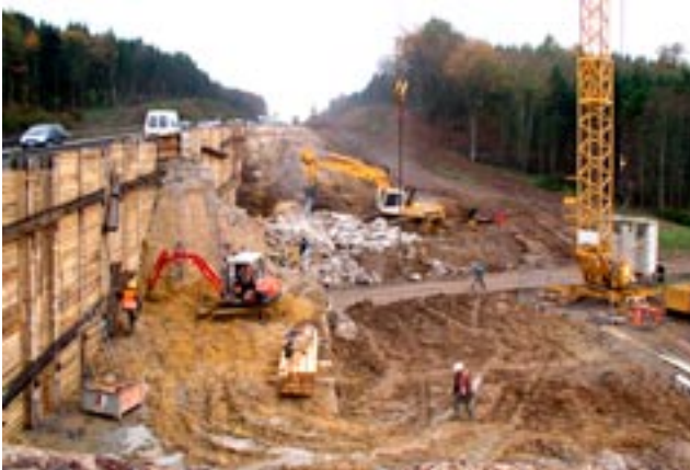
Verbau an der BAB A 5 zur Sicherung und Aufrechterhaltung des Verkehrs, Höhe ca. 12 m
