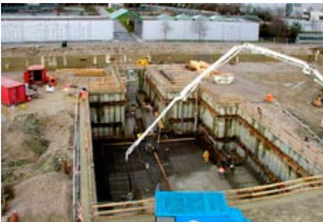
Bohrpfahlwand am Klärwerk München, 2-fach rückverankert
