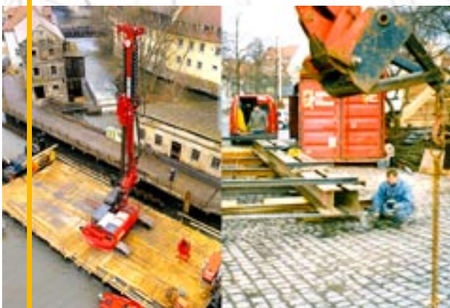
Rammarbeiten vom Ponton aus in Bamberg
