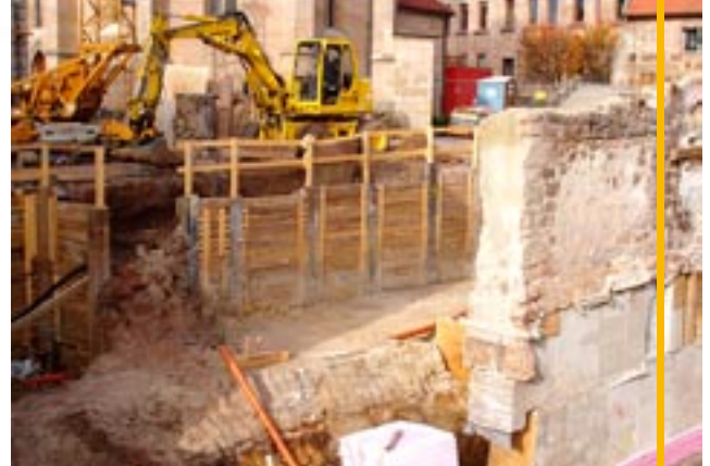
Trägerbohlwand und Unterfangung im denkmalgeschützten Bereich-Gemeindezentrum Herzogenaurach
