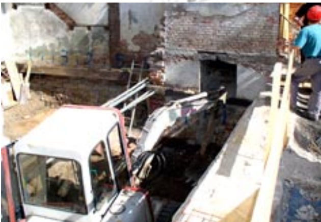
Unterfangungen alter Fundamente an der Synagoge Bamberg
